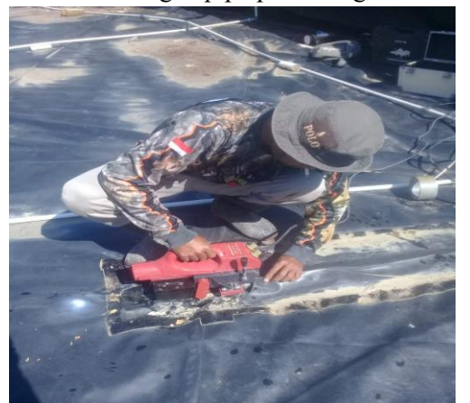
Perbaikan terpal bocor
