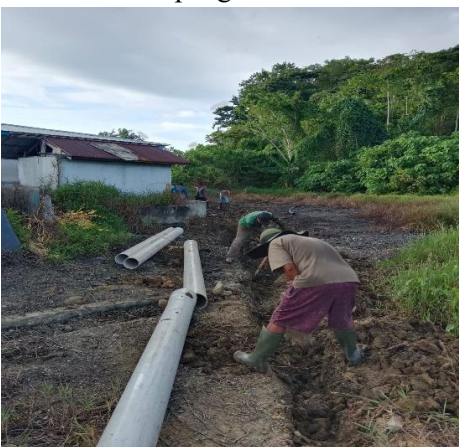
Pemasangan pipa inlet
