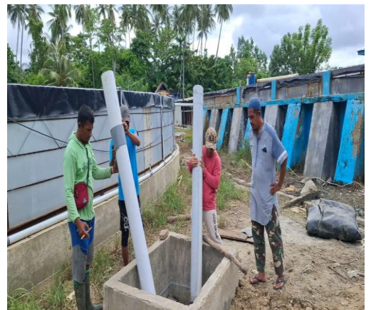
Pemasangan pipa pembuangan
