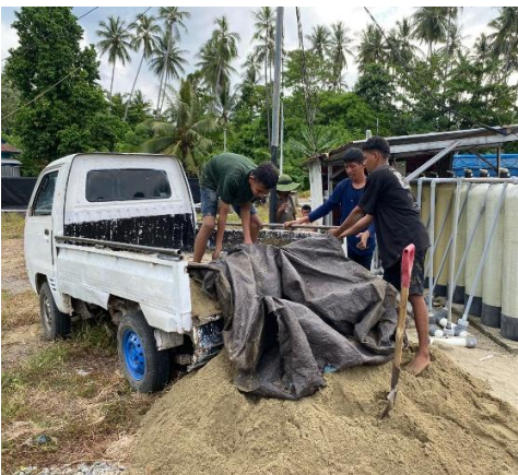
Material pengecoran tandon
