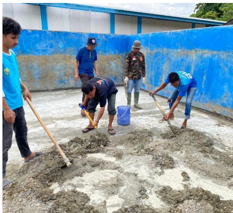
Pengecoran tandon yang bocor
